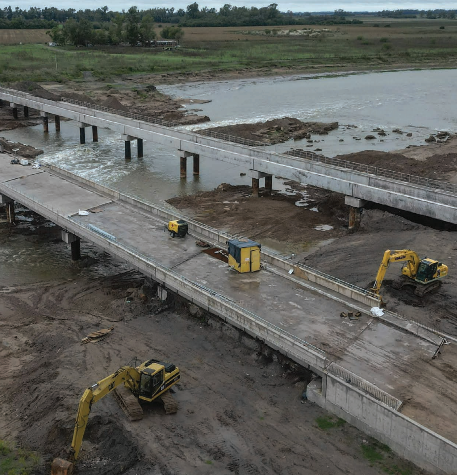
Construcción de puentes en Roque Pérez | Obra complementaria del Plan Maestro Integral de la cuenca del río Salado (tramo III)
