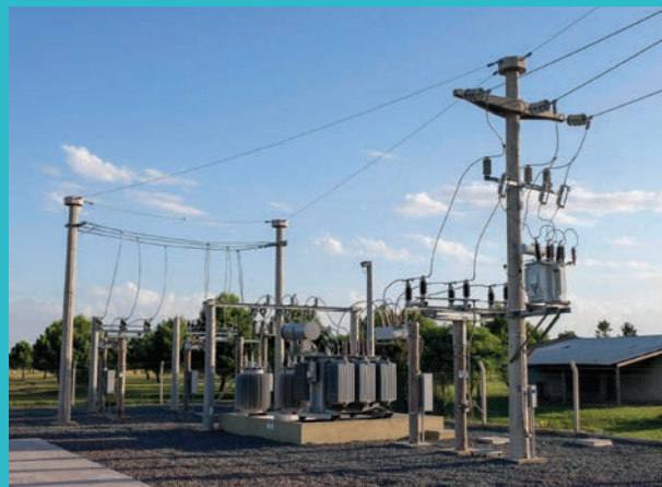
El MISP avanza con nuevas obras de 132 kV en distintos municipios.
